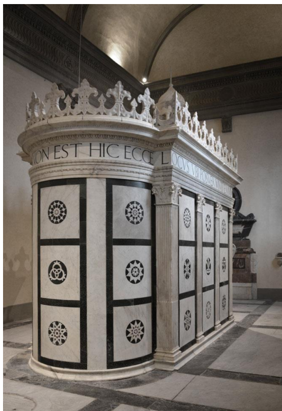
Sepolcro Rucellai. Una piccola cappella funeraria costruita all'interno della Cappella Rucellai della chiesa di San Pancrazio, Firenze. È stato commissionato da Giovanni di Paolo Rucellai e costruito su progetto di Leon Battista Alberti a imitazione o l'emulazione del Santo Sepolcro nelle Anastasis in Gerusalemme. Vi sono contenute le tombe di Giovanni Rucellai e membri della sua famiglia. (Immagine da http://www.italianways.com )
